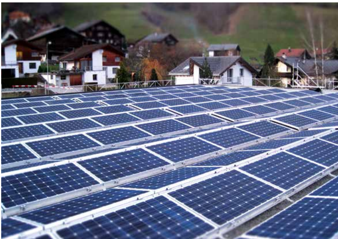
Installaziun d'in indrez fotovoltaic entras l'energia alpina a Trun
